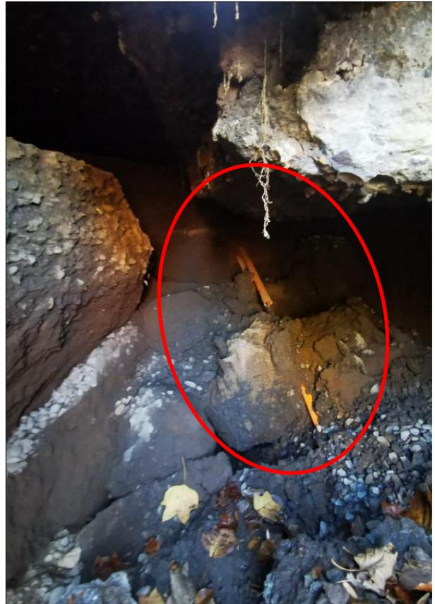
*Ilustración 5.- situación de terreno, socavamiento de terreno soportante bajo hormigón de calzada con compromiso de daño a red eléctrica de alumbrado público.*
