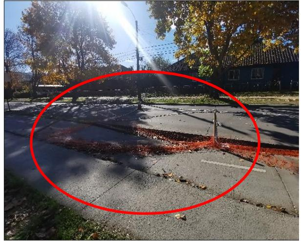
*Ilustración 3.- situación de terreno, socavamiento de Ciclovía en calle José Bunster, se aprecia desniveles de socavamiento de ciclovía con respecto a solera.*
