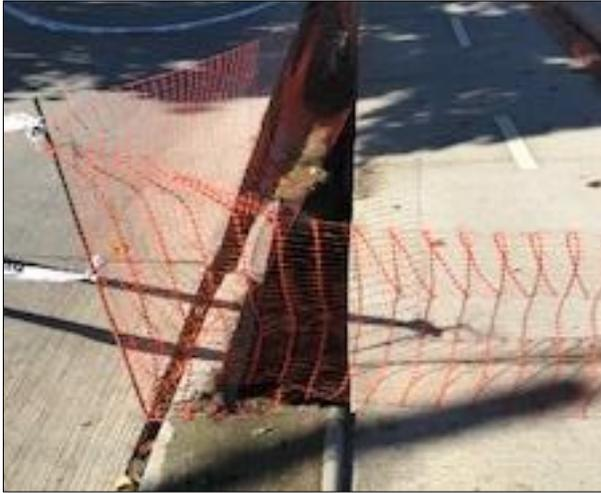
*Ilustración 6.- situación de terreno, socavón producto de colapso de colector aguas lluvias.*
