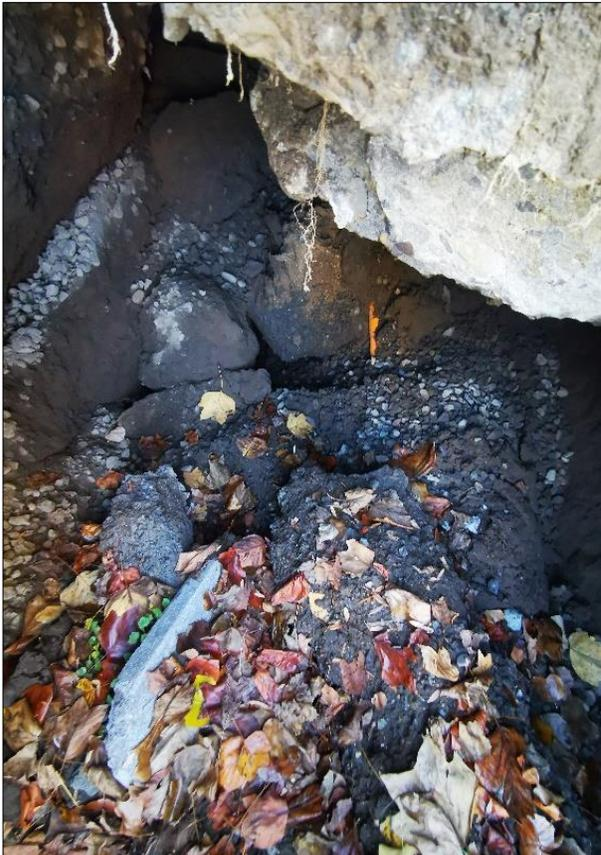
*Ilustración 4.- Situación de terreno, socavamiento de terreno soportante bajo hormigón de calzada en pista lado sur.*
