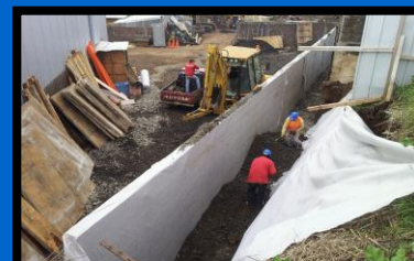
Muro Contención Tromén Lafquen
