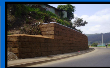
Muro Contención Calle Argentina
